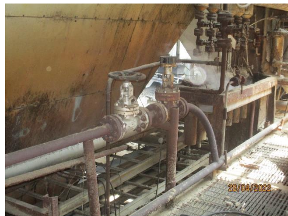
ลิ้นระบายหม้อไอน้ำ (Blow down Valve)
