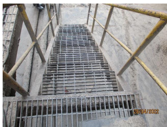
บันไดและทางเดินสำหรับหม้อไอน้ำ
